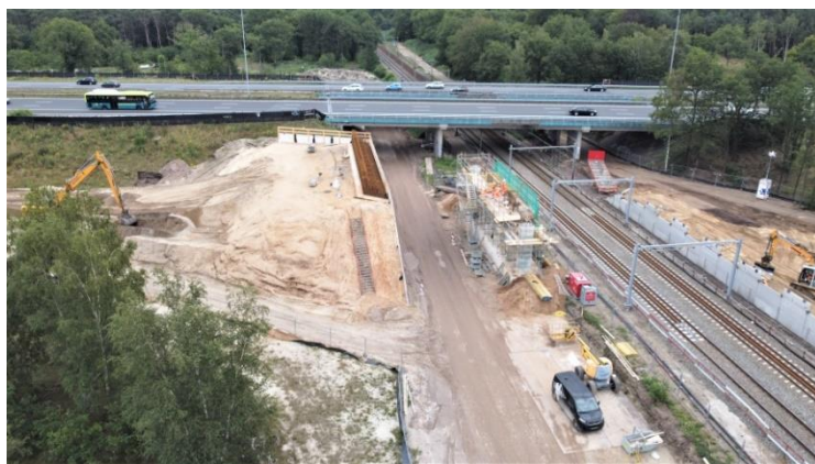
Gedeelte van de nog in aanbouw zijnde fly-over voor de HOV.
